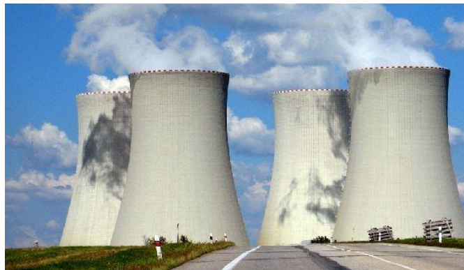
Figura 2 – torres de arrefecimento com circulação natural do ar
