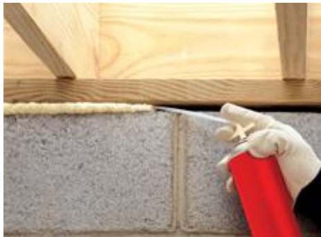
Figura 5. Espuma vedante e isolante de poliuretano usada em construção civil.
