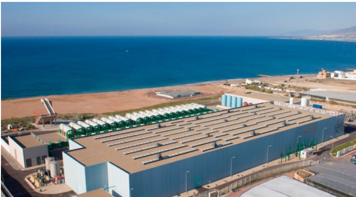
Figura 1. Vista aérea de uma estação dessalinizadora de osmose inversa em duas etapas para produção de água para consumo humano e rega, localizada no sul de Espanha [6].
